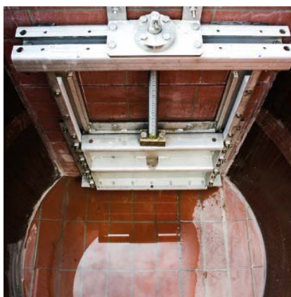
Montage van schuifafsluiter
