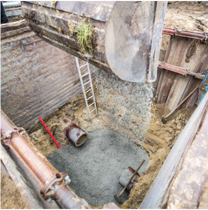
Aanleggen van de funderingsgrondslag
